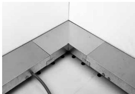
8. Raccordement des tubes vides, si nécessaire. Ouvrir au préalable les pré-découpes avec un tournevis plat. Raccordement possible des tubes vides sur quatre côtés.
