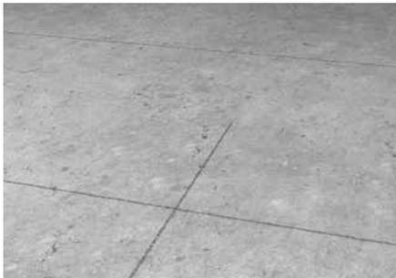
Marquez le cheminement sur la dalle, par exemple avec de la craie ou de la ficelle. Vérifiez le nivellement de la dalle.
