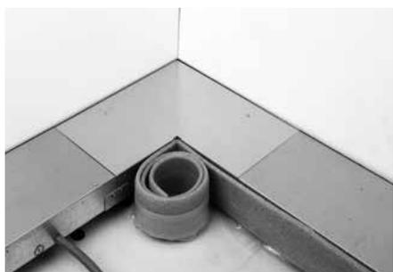
10. Pose de la bande isolante sur la paroi de la goulotte côté chape (veiller à ce que la chape ne coule pas sous la goulotte). Respecter les mesures particulières à prendre en cas d'utilisation de chapes liquides, chauffées ou agressives. Suivant le revêtement utilisé (p. ex. matériau liquide), il faudra consulter le fabricant. Si une autre bande isolante est nécessaire sur la paroi de la goulotte côté mur, elle doit être posée avant d'effectuer l'étape de montage n° 4.
