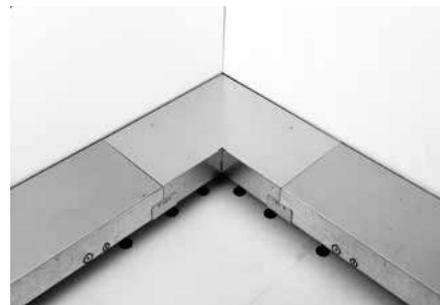
9. Vissage du couvercle de protection à l'aide des vis autotaraudeuses fournies avec la goulotte (dans l'emballage sous film plastique collé). Ces dernières sont vissées directement, sans perçage préalable, sur la surface d'appui de la base de la goulotte à travers les orifices du couvercle de protection.
